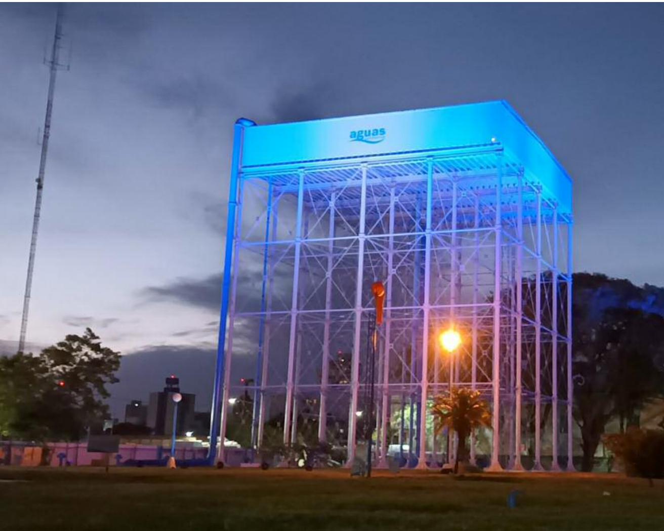
Planta Potabilizadora Ingeniero Marcial Candiotti
