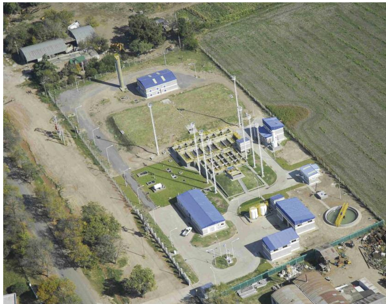
Planta potabilizadora - Acueducto Centro Oeste. Santa Fe - Argentina
