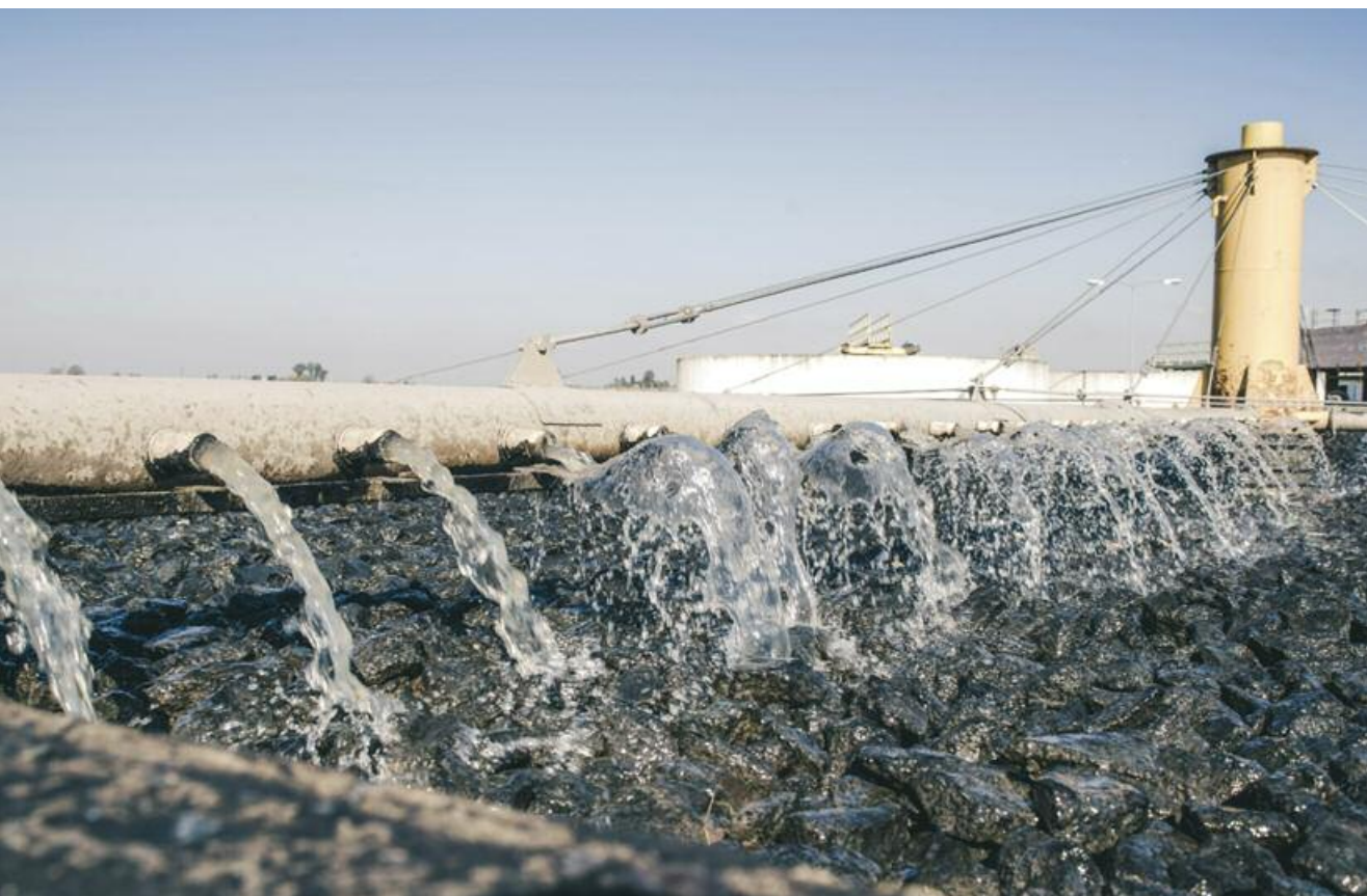
Tratamiento de aguas residuales
