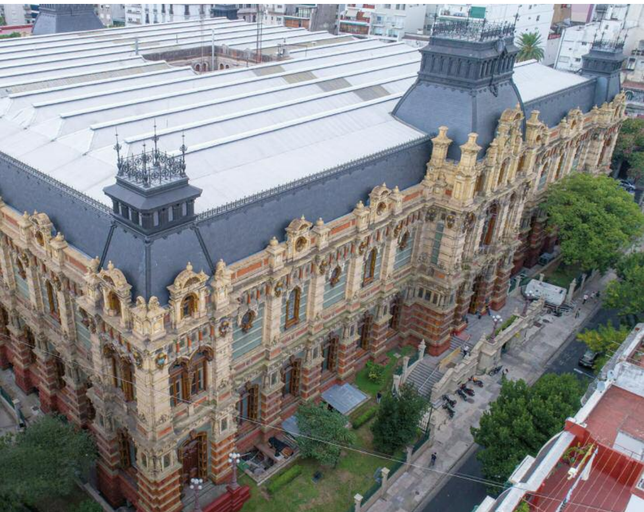
Palacio de las Aguas Corrientes - CABA. Fuente: AySA
