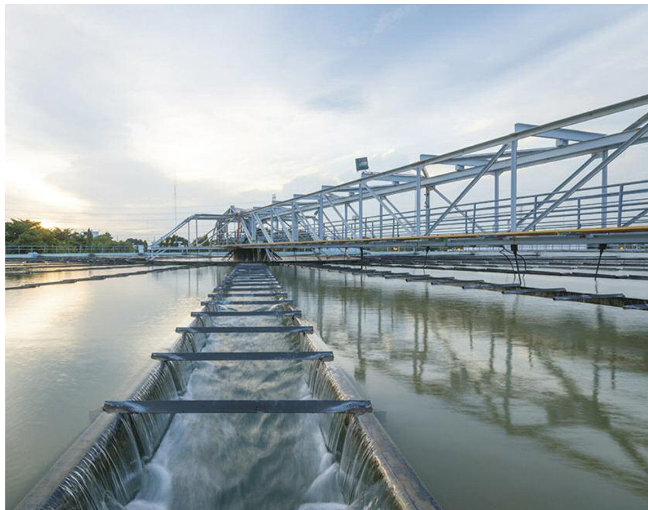
Tratamiento de aguas residuales
